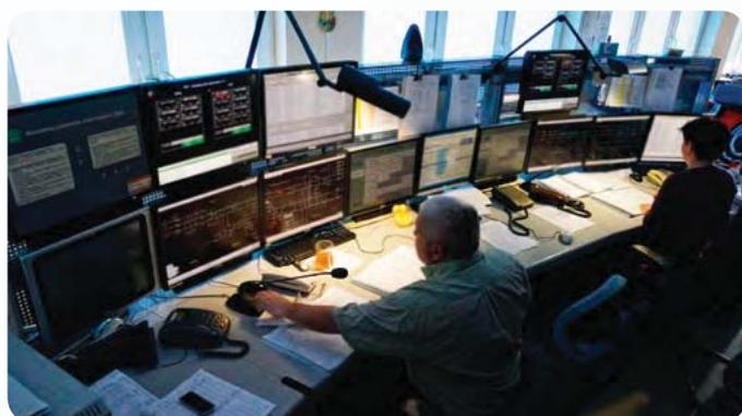
Fot. 1. Stanowisko sterowania ruchem kolejowym nowego typu (komputerowy system sterowania ruchem kolejowym)
