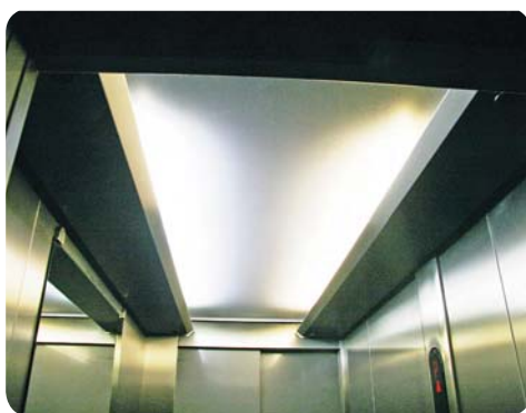
Fot. 6. Przykładowe oświetlenie pośrednie kabiny dźwigu osobowego
