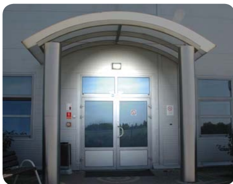
Fot. 5. Przykład zalecanego oświetlenia drzwi wejściowych do budynku [3]
