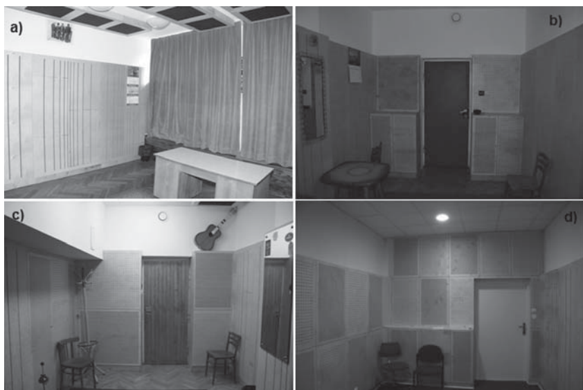
Rys. 7. Przykłady realizacji adaptacji akustycznej sal do nauki gry na instrumentach: a) trąbce (widać kotary, ustrój szczelinowy, ustrój sufitowy), b) saksofonie i waltorni (widać ustrój szczelinowy i ustroje perforowane), c) puzonie (widać ustrój szczelinowy i ustroje perforowane), d) instrumentach perkusyjnych (widać ustrój szczelinowy i ustroje perforowane oraz sufit podwieszany)
