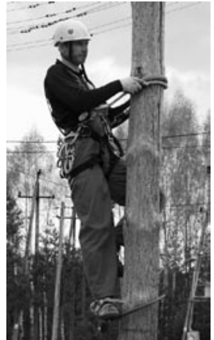
Rys. 1. Przykład zastosowania systemu ustalającego pozycję podczas pracy na słupie żerdziowym
