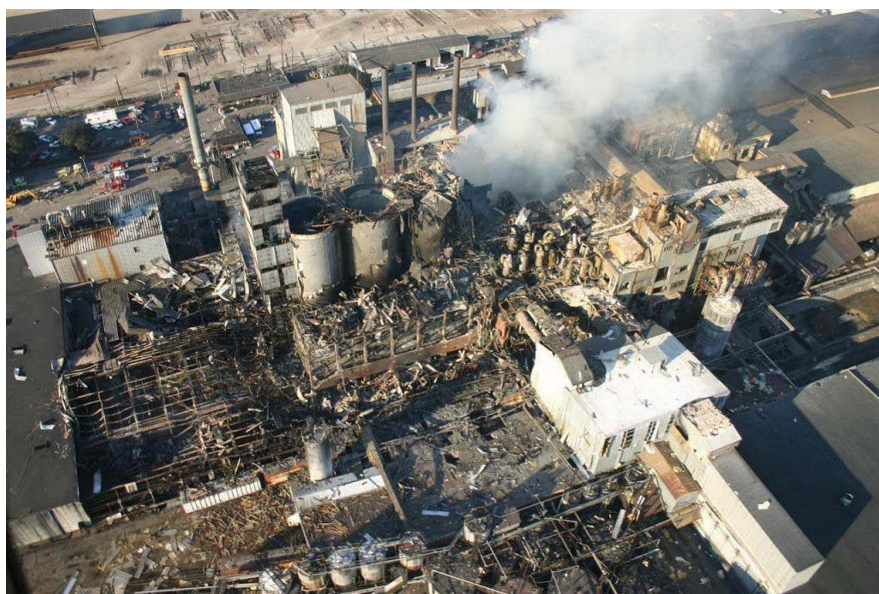
Rys. 1. Skutki wybuchu pyłu cukrowego w Imperial Sugar Company w 2008 roku [źródło: OSHA, Investigation Report, Sugar Dust Explosion And Fire, Imperial Sugar Company, Report No. 2008-05-I-GA ]
