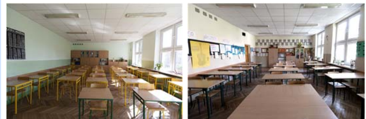
Fot. Widok sal lekcyjnych z zainstalowanymi dźwiękochłonnymi sufitami podwieszanymi
