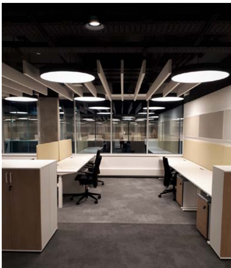
Fot. 5. Dobra praktyka: Adaptacja akustyczna podłogi, sufitu i ścian
