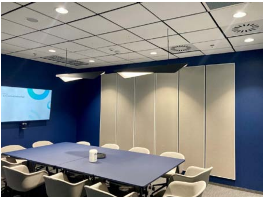
Fot. 2. Dobra praktyka: Pomieszczenie wspierające (sala spotkań) z adaptacją akustyczną sufitu i ścian
