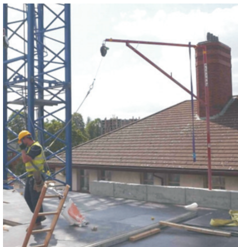
Rys. 5. System Alsipercha przeznaczony do asekuracji pracowników podczas prac montażowych na wysokości
