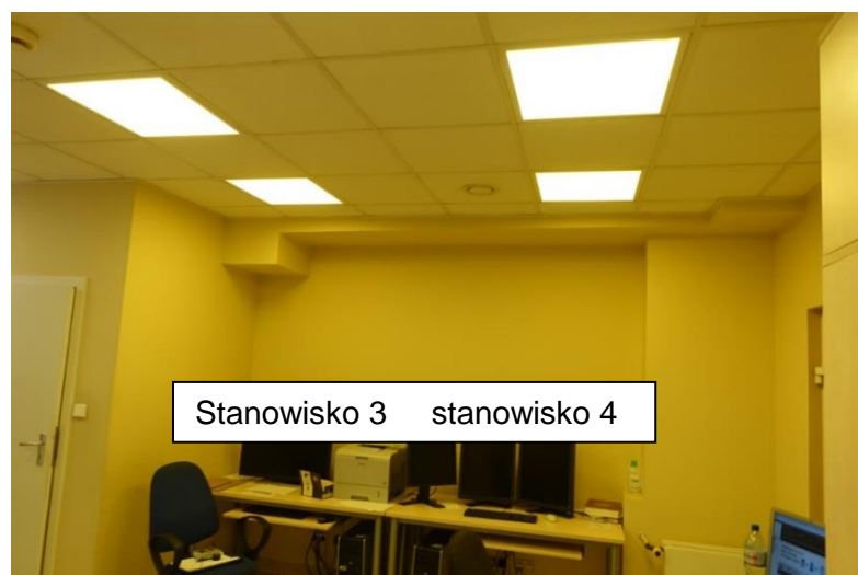
Rys. 5.26. Widok opraw oświetleniowych i stanowisk pracy
