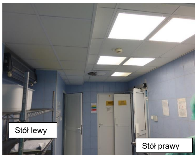
Rys. 5.47. Widok stołu do przygotowania narzędzi w bocznym pomieszczeniu (bez okna)
