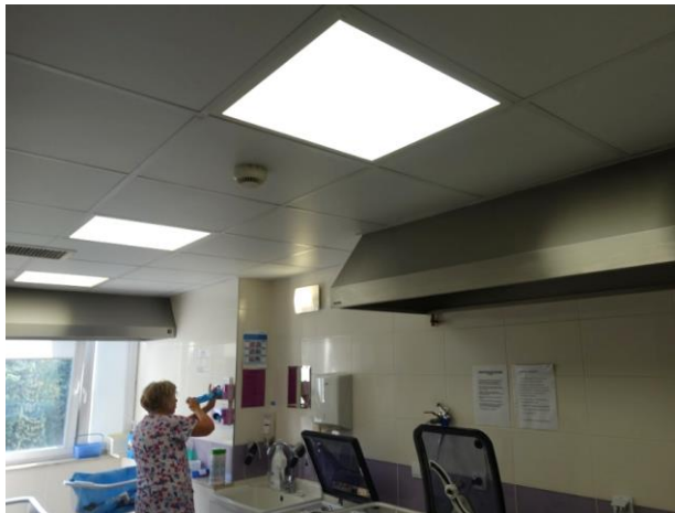
Rys.5.53. Widok pomieszczenia myjni
