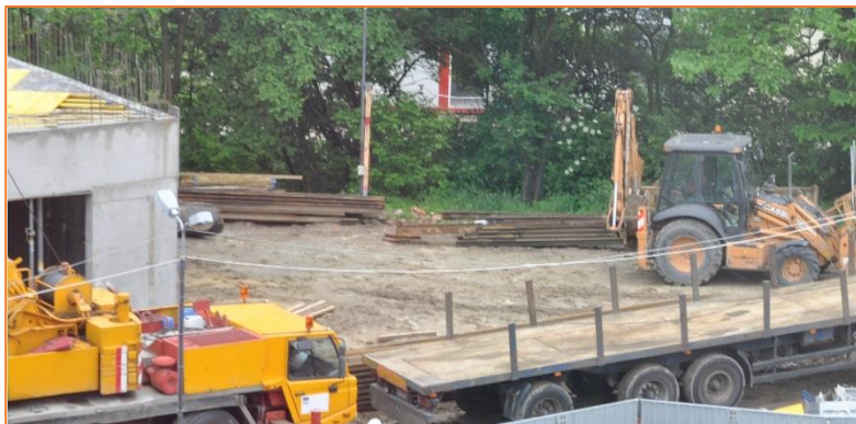
Rys. 13. Przykład miejsca pracy, gdzie hałas tła jest związany z prowadzonymi pracami budowlanymi
